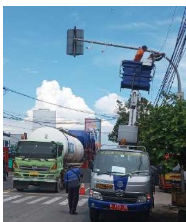
Gambar 3. 1 Dokumentasi Pemasangan CCTV
