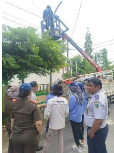
Gambar 3. 2 Dokumentasi Monitoring Pemasangan LPJU
